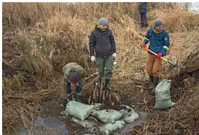
Рис. 93. Создание временной земляной плотины на трубопереезде (обводнение, создание места для забора воды пожарной техникой). Тверская область
